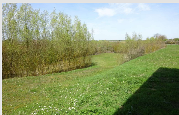
18/ Bassin d'orage - Lotissement des Tamaris - juin 2020
