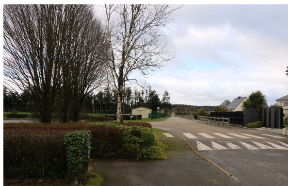
9/ Entrée de bourg - Rue des Bruyères - janvier et mai 2021
